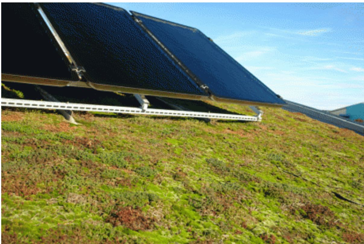
54. ábra: Modell ipari park pillére eleme: Zöldtető és napelem kombinációja ( http://www.passzivhaz-magazin.hu ): a zöldtető növeli a napelem hatásfokát.
