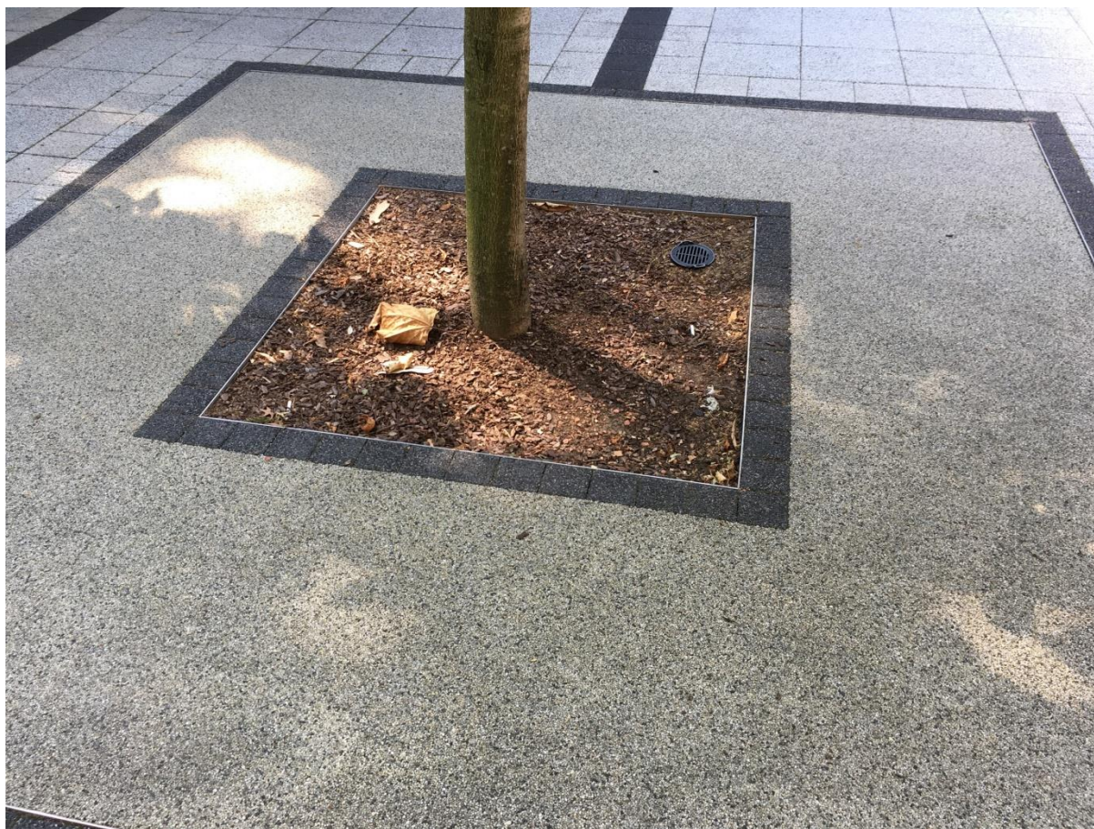
Fatörzs körül (1x1m) mulcsozott felület dréncső kivezetéssel, ültető gödör felszínén műgyanta kötőanyagú vízáteresztő burkolat fém szegéllyel, ültető gödrön kívül beton térkő burkolat. Helyszín: Budapest, Gundel Étterem kerthelyiség
