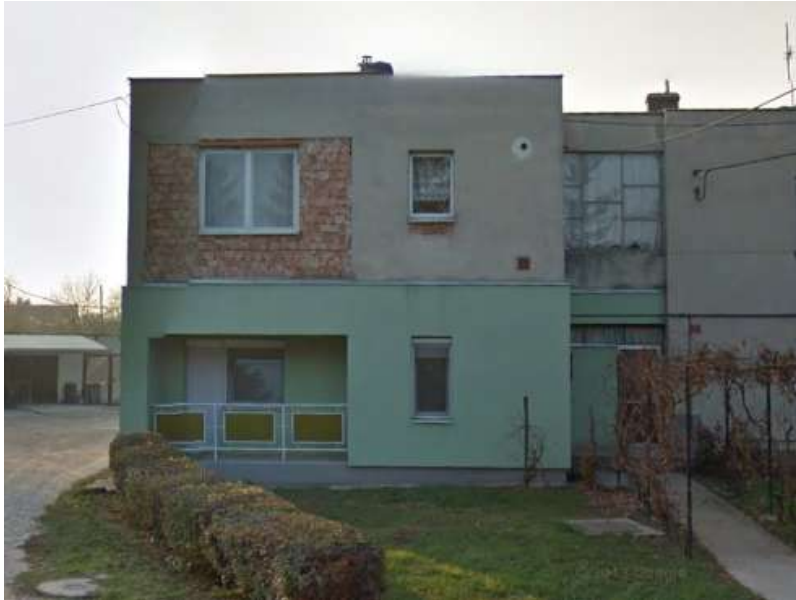
Társasháznál egyedileg megvalósított homlokzatszigetelés, bővítés
